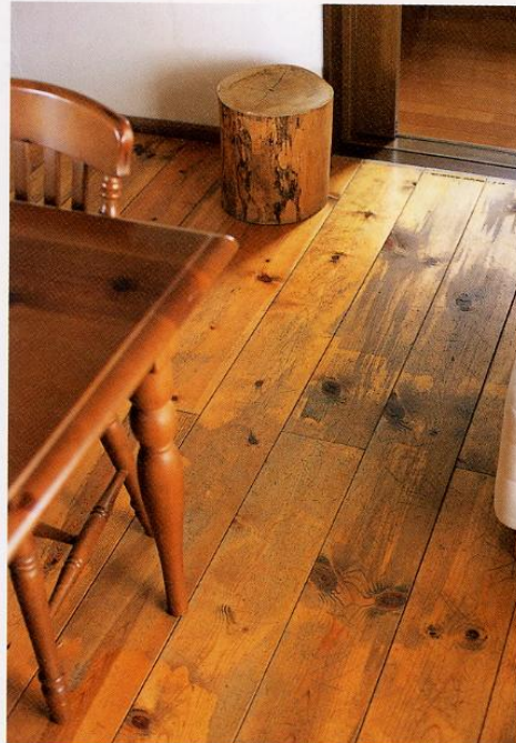
もとの畳をはがした床にはバイン材のフローリングを直貼り。素足に優しい感触のバイン材や接着剤は、インターネットの建材屋さんに注文したので、購入時は運搬の苦労はナン。丁寧な仕上げはプロ願負いです。
