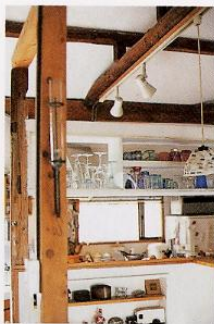
部屋の照明配線は、むき出しになった柱に沿って通っています。カバーでおおって目立たぬようにしました。スイッチボックス(写真右)が愛らしげ。
