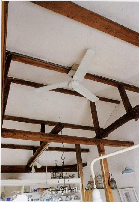
梁や柱はオイルステイン仕上げ。壁と天井は石膏ボード(下地材)を貼って、水性ペンキ仕上げに。高所の作業は重労働ですが、最後に天井扇を設置してアクセント。寒い冬に暖気をほどよくまわしてくれます。
